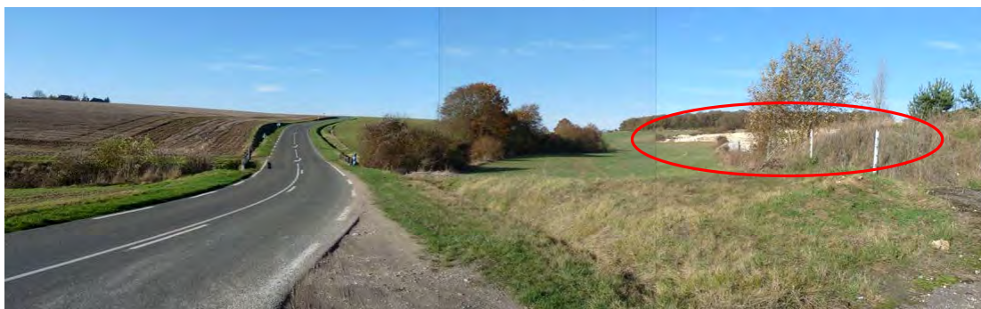
Photo 4 : Prise de vue n° 3 du site d'exploitation depuis la RD63 à proximité de l'entrée de la carrière
